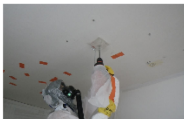
Chantier réduction du risque amiante Aorif
