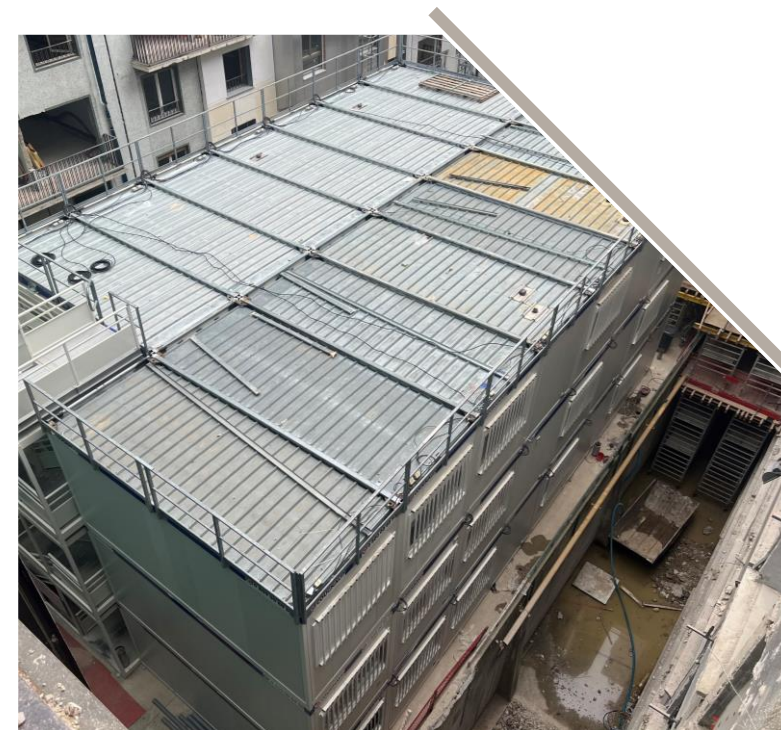
Raccordement des réseaux !
